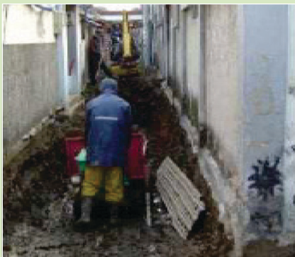
上下水道など基盤施設整備
